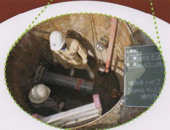
さや管内に埋設管を挿入し、中込注入します。
