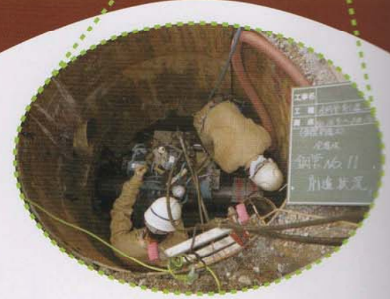
メタルクラウンと鋼管を、左右に回転推進します。
