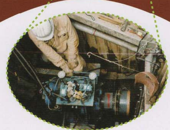
メタルクラウンと鋼管を、溶接接合し 推進機にセットします。
