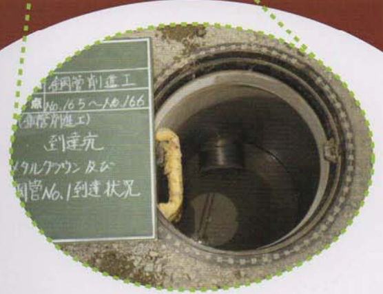
到達したら、メタルクラウンを回収し、 鋼管を回転させ、ズリ出しをします。
